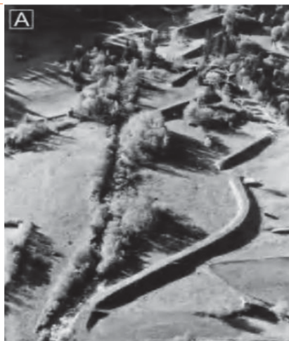
Слева: несколько канав для прохождения грязевых потоков в конусе выноса с бурными потоками (Бергмейстер, Суда, Хюбл и Рудольф-Маклау, 2009)
