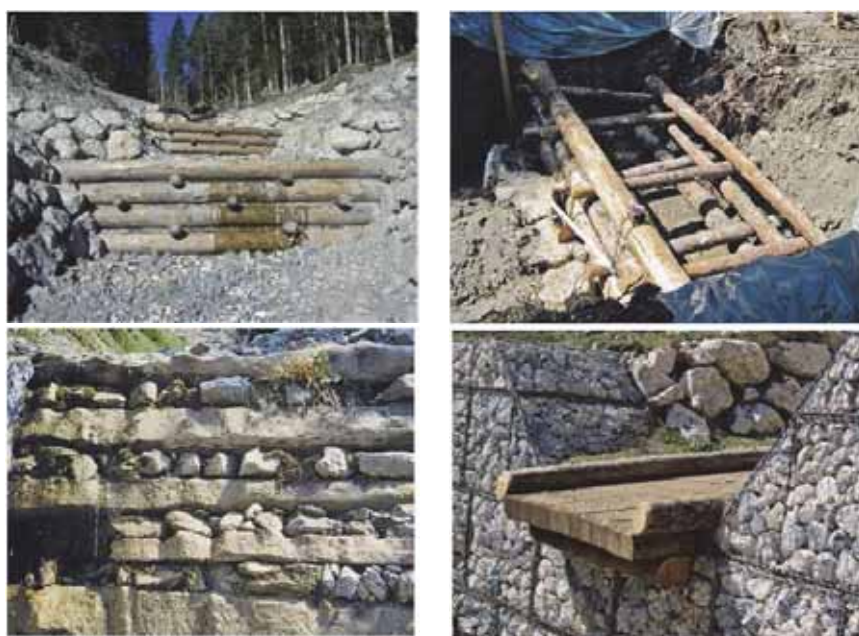
Вверху: небольшие деревянные противопаводковые дамбы, внизу: небольшая каменная противопаводковая дамба, справа – с металлической габионной сеткой (Римбок, Хэн, Майер, & Вольтер-Краутблаттер, 2015)
