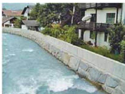
Меры продольной защиты: бетонная стена (слева), каменная стена (справа); (Римбок, Хэн, Майер и Волтер-Краутблаттер , 2015)
