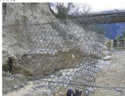
Схематическая конструкция гибкого барьера для грязекаменного потока (Венделер, 2016)
