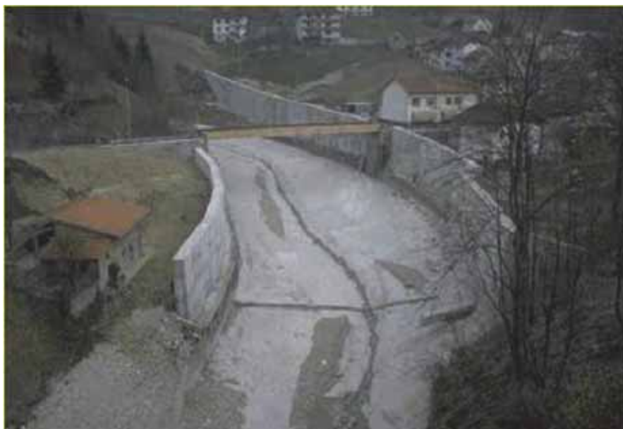
Проведение грязевых потоков через села в Италии через ответвленный канал. После бедствия канал можно промыть, направив в него потоки воды (Неизвестно )
