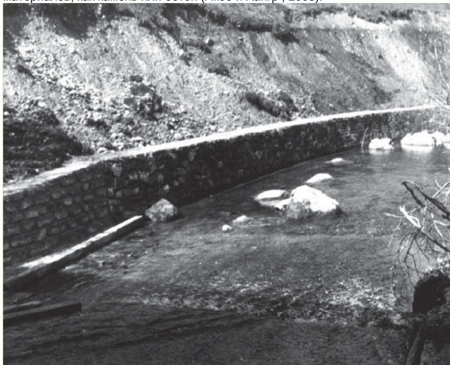
Продольная стабилизация размываемого склона (Якоб и Хангр , 2005)
