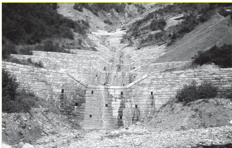
Поперечная стабилизация размываемого склона, Австрия (Якоб и Хангр, 2005)
