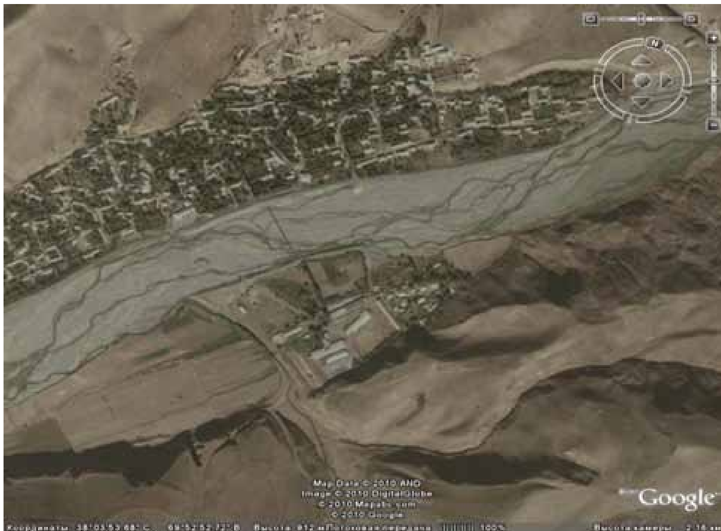
Кишлак Дахана. Разрушение берегов селевым потоком
