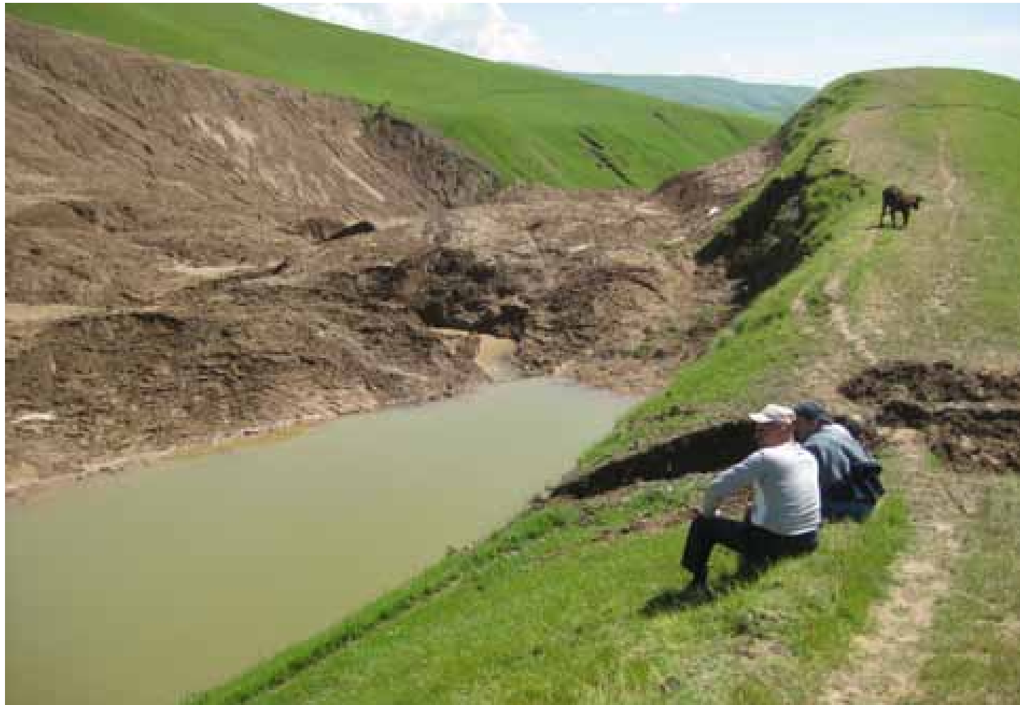
Оползень Куль. Перекрытие русло сая с образованием озеро длиной 100 м.
