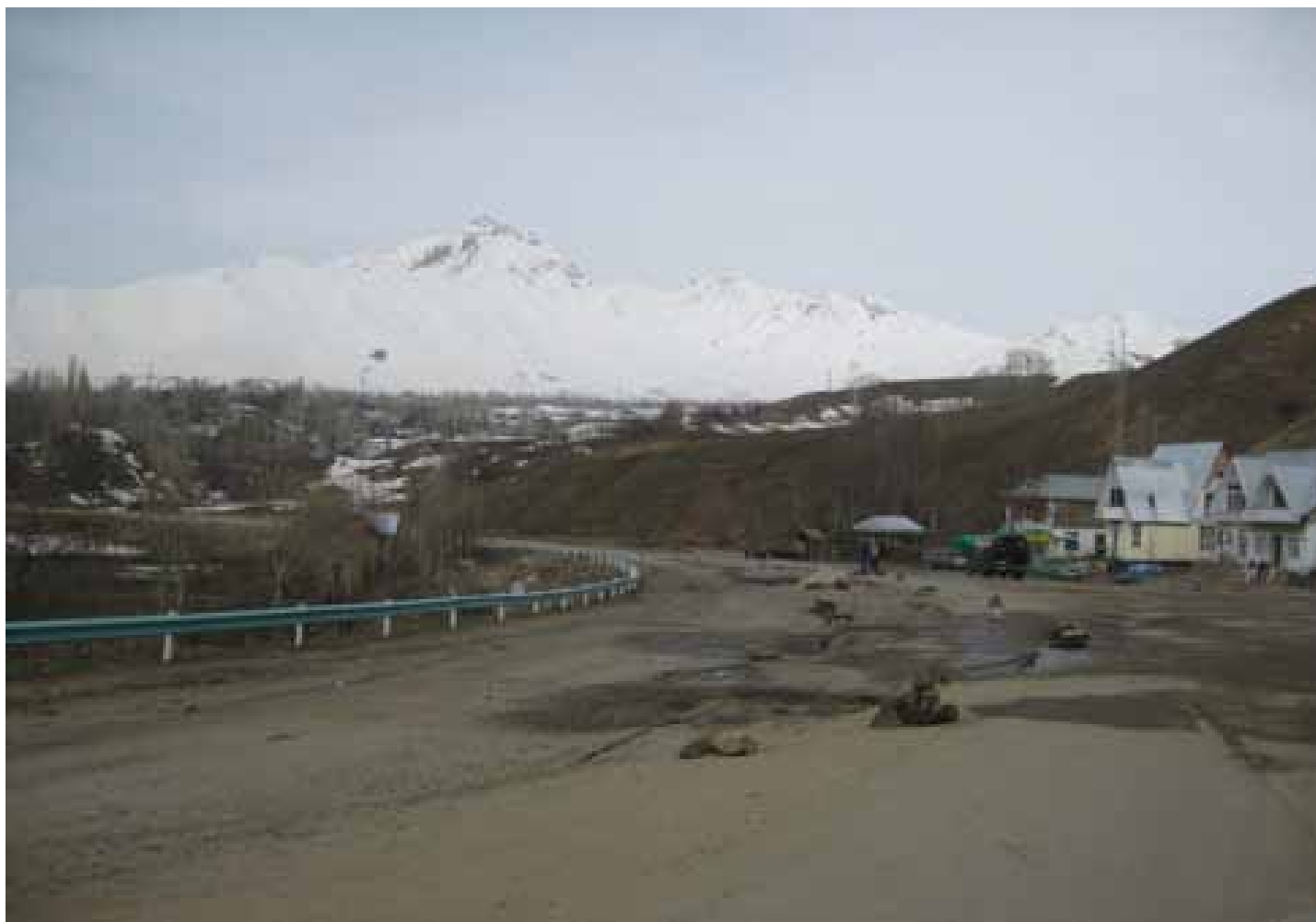
Оползень с захватом автодороги кишлак Калаи-Нав
